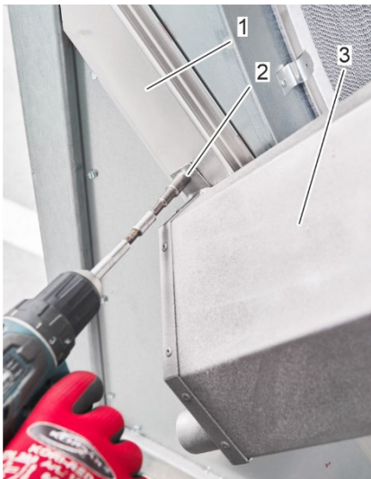
Abbildung 53: Montage der Auffangschale
