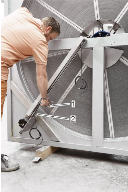
Abbildung 38: Untere Position des Reinigungsschlittens
